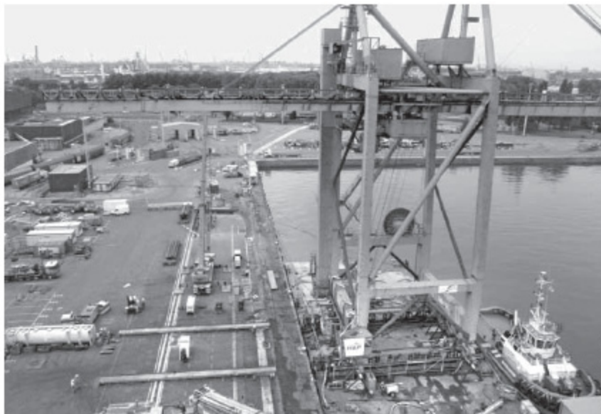
Mit dem „Air-Pad System“ können Stückgewichte bis zu 2400 Tonnen verschoben werden
